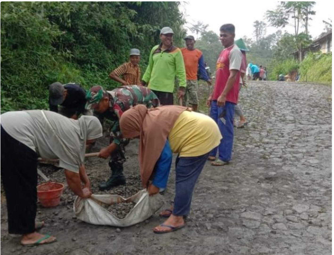
Babinsa Plumpung Koramil 0804/02 Plaosan Bersama Warga Kerja Bakti Bersihkan Jalan Penghubung Desa
